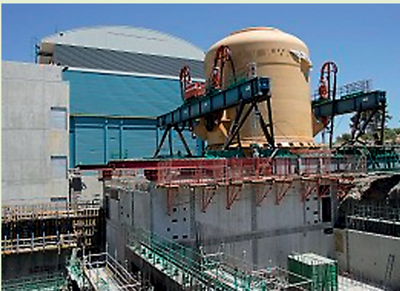
Fig. 8. The construction site of the test reactor RES ( Réacteur d'Essais ), with the emplacement of the metallic containment.
